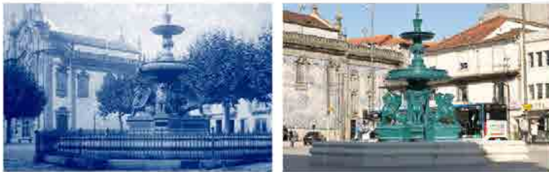
Figura 8 | Fonte dos Leões original (esquerda) e Fonte dos Leões após a reabilitação profunda, concluída em 2023 (direita)
